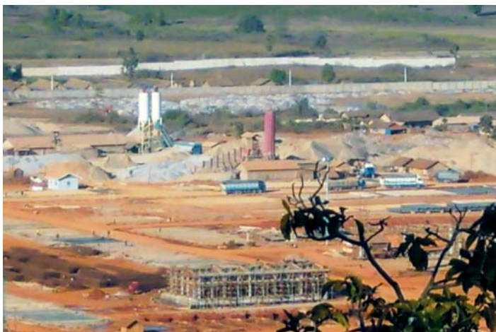
သံစက်ရုံအတွင်း တည်ဆောက်ရေးလုပ်ငန်းခွင် တခု။ ၎င်းလုပ်ငန်းခွင်ကို ကာရံထားသောနံရံသည် (နောက်တွင် မြင်နေရသည်) စတင် တည်ဆောက်လျက်ပင် ရှိသေးသည်။ (ဓါတ်ပုံ- ၂၀၀၇ ဒီဇင်ဘာလ)
