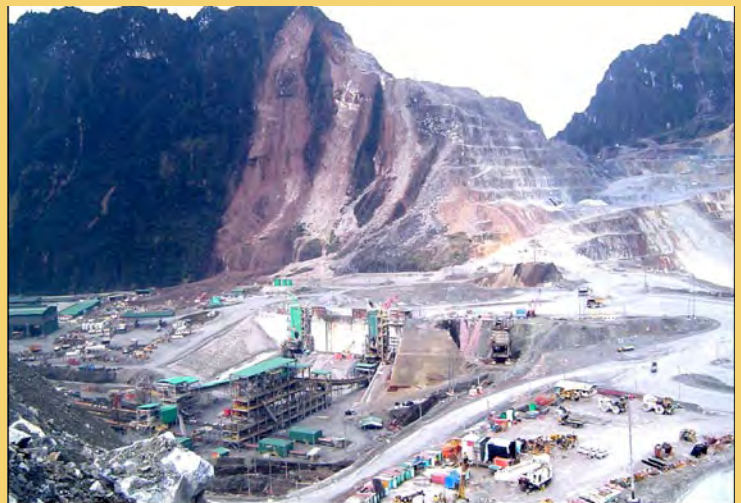
Daerah yang terlanda material longsor yang terdiri dari mess, laboratorium dan penyimpanan kontainer, terletak pada dataran di kaki lereng
