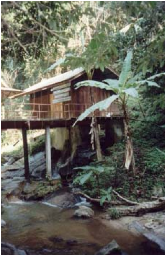
ระบบไฟฟ้าพลังงานน้ำขนาดเล็ก ของชุมชนที่หมู่บ้านแม่กำปอง จังหวัดเชียงใหม่ (ภาพ: กลุ่มพลังไท) A 40 kW grid-connected community micro-hydro at Mae Kam Pong village, Chiang Mai, Thailand. (Photo: Palang Thai)
