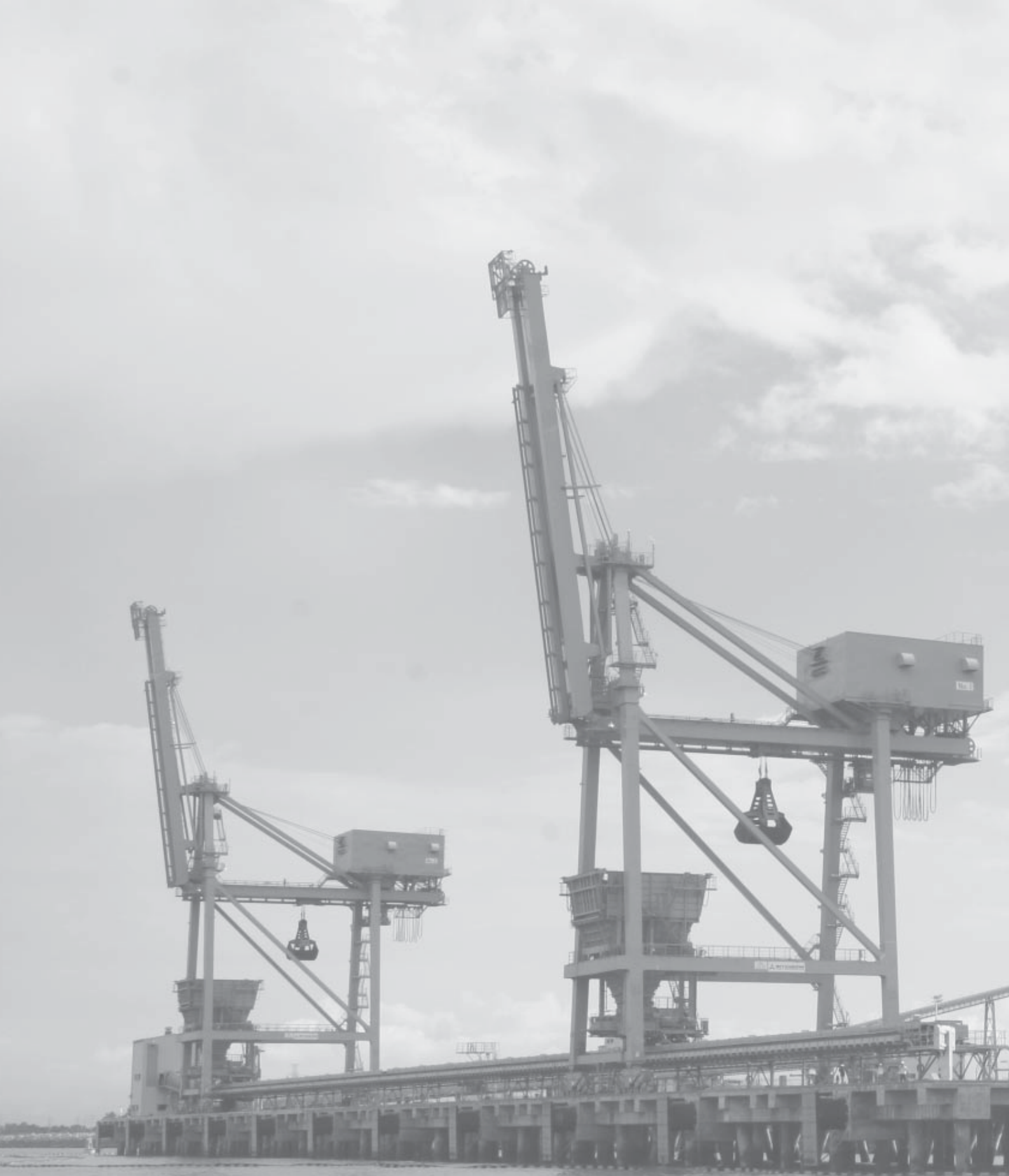
โรงไฟฟ้าถ่านหินบีแอลซีพี กำลังการผลิต 1,434 เมกะวัตต์ ที่นิคมอุตสาหกรรมมาบตาพุด จังหวัดระยอง ร่วมทุนระหว่างบริษัทไชน่าไลต์แอนด์เพาเวอร์และบริษัทبانปู จำกัด(มหาชน) มูลค่าการลงทุน 54,800 ล้านบาท แหล่งเงินทุนหลักคือธนาคารพัฒนาเอเชียและธนาคารแห่งญี่ปุ่นเพื่อความร่วมมือระหว่างประเทศ โรงไฟฟ้าถ่านหินแห่งนี้ นำเข้าถ่านหิน 3.5 ล้านตันต่อปี ภายใต้สัญญาซื้อขายถ่านหิน กับบริษัท ริโอติंटอแห่งออสเตรเลียเป็นเวลา 25 ปี (ภาพ: กรีนพีซ/วินัย ดิษฐาน) BLCP Coal Plant, a 1,434 MW coal-fired power station at Map Ta Phut Industrial Estate, Rayong, Thailand owned by Hong Kong-based China Light & Power and Banpu Plc and funded by Asian Development Bank and Japan Bank for International Cooperation. This coal plant requires approximately 3.5 million tones of Australian coal per annum delivered by Rio-Tinto.(Photo : Greenpeace/Vinai Dithajohn)
