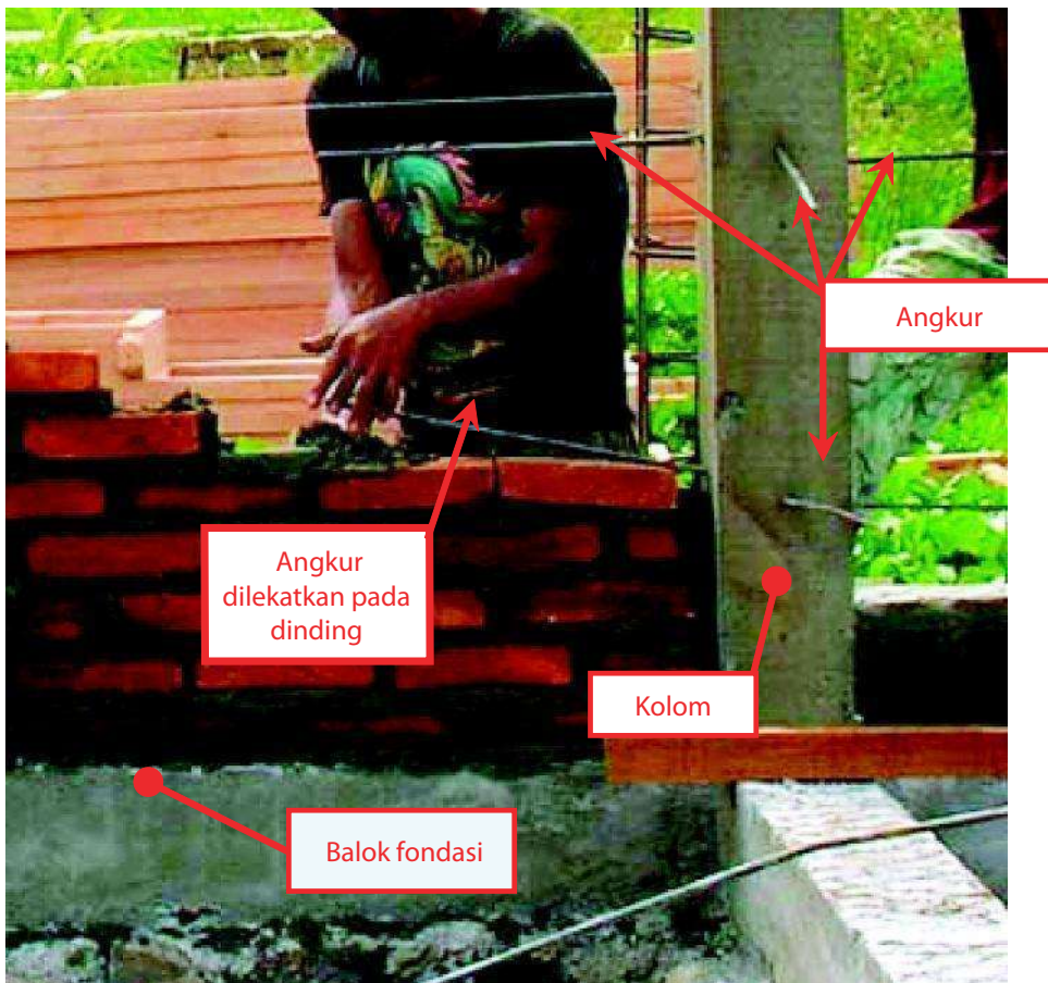
Sambungan kolom ke dinding.
