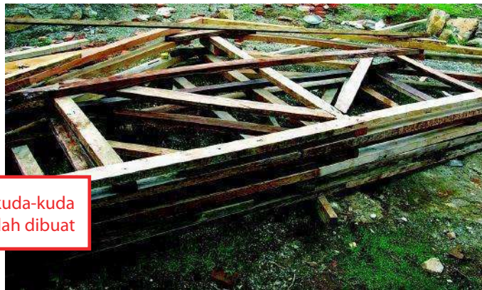
Pembuatan Rangka Kuda-kuda.
