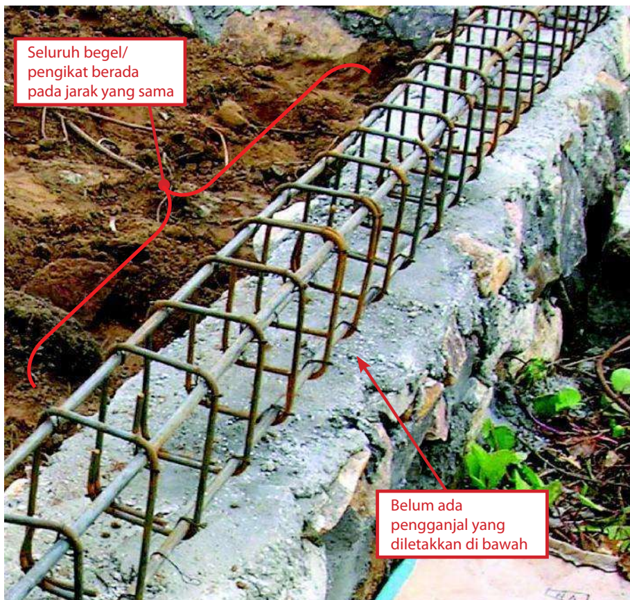
Penulangan dikerjakan dengan baik.
