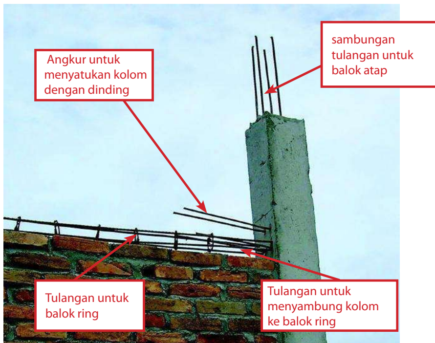
Sambungan tulangan untuk balok, dinding dan kolom.
