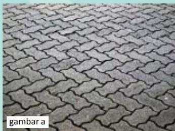
Metode pembuatan areal peresapan air hujan merupakan koreksi atas perkembangan akhir-akhir ini. Permukaan tanah pekarangan, baik di perkotaan, pinggiran, maupun pedesaan, dilapisi dengan *concrete paving blocks* (konblok) yang dipasang secara rapat (gambar a)
