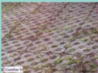
atau dengan plesteran dari semen dan pasir. Hal ini berdampak pada penurunan koefisien resapan air hujan ke dalam tanah. Oleh karena itu, perlu dilakukan koreksi dengan cara menutup permukaan tanah dengan rumput atau bila diperlukan perkerasan dapat menggunakan *porous paving block* atau *grass block* (gambar b). *Grass block* dapat dipakai pada areal parkir, *carport*, areal untuk pejalan kaki, dsb.
