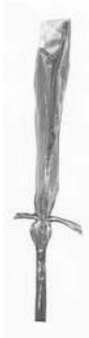
8. Sambungan diselubungi dengan kantong plastik
