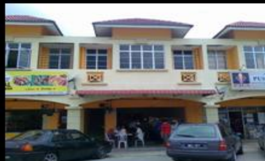
Bangunan Kedai Pejabat , Permint Jaya, Chendering, Kuala Terengganu.
