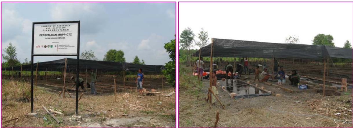
Gambar 18. Pembangunan Persemaian di Desa Muara Merang (koordinat S2 08.039 E104 07.481)
