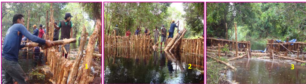
Gambar 15. Pembuatan Kanal Bloking di Sungai Tembesu Daro (foto: 1 - 3)
