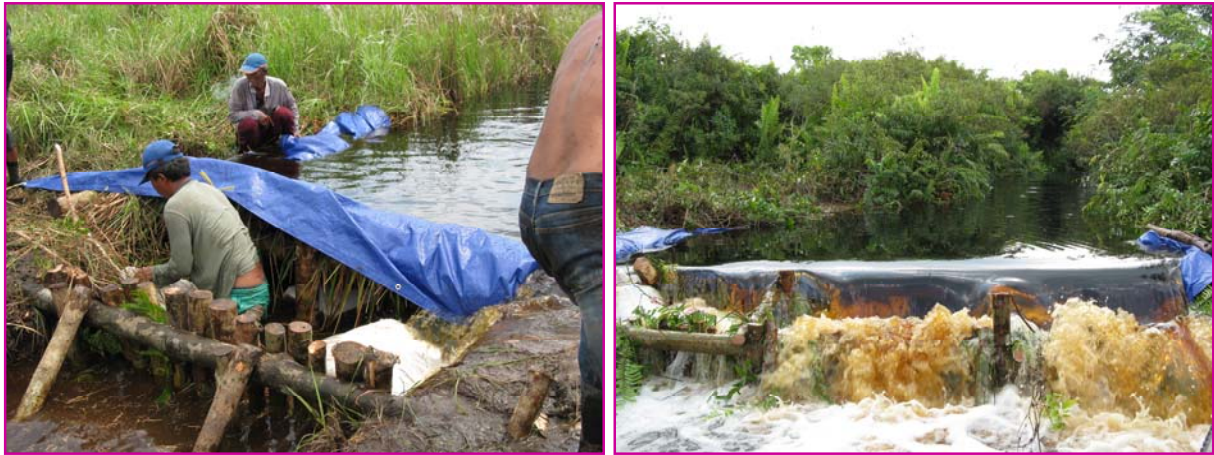
Gambar 14. Pembuatan Kanal Bloking di Sungai Kepayang Km. 10 (kiri) dan Km. 14 (kanan)
