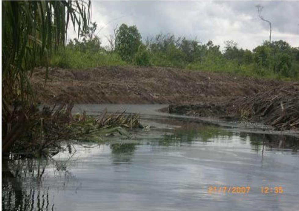
Gambar II-4. Pembuatan kanal saluran drainase ke Sungai Mantangai pada ekosistem hutan gambut tebal
