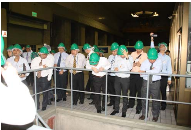
ทางลงไปชั้นที่มีการติดตั้งเครื่องกังหันน้ำแบบสูบกลับ
