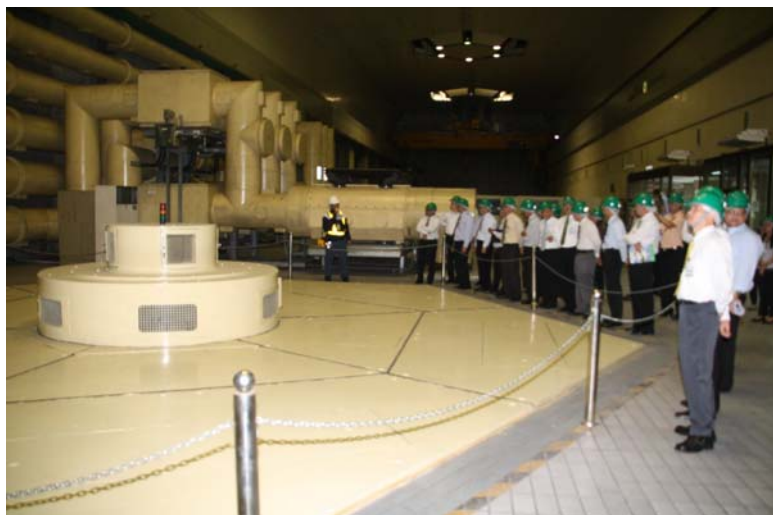
ส่วนบนของตัวเครื่องผลิตกระแสไฟฟ้า
