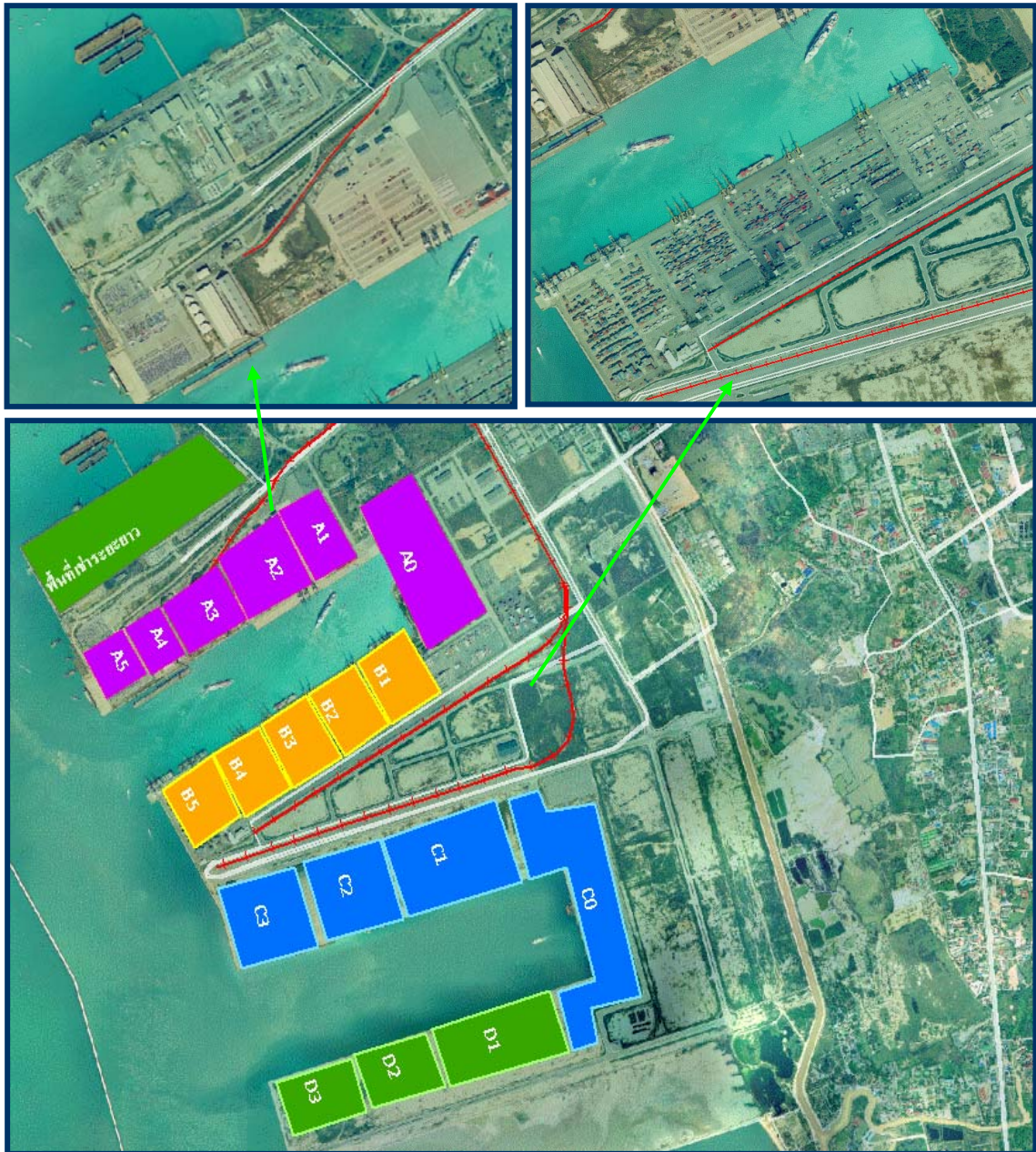
ภาพที่ 3-25 แสดงโครงข่ายรถไฟภายในท่าเรือแหลมฉบัง
