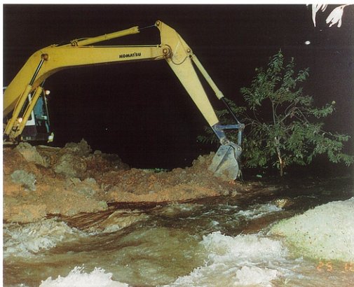
การเจาะคันให้น้ำเข้าข้างในสระ Making a breach in the dyke.
