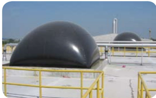
บ่อบำบัดน้ำเสียและผลิตก๊าซชีวภาพ ขนาด 6,000 ลูกบาศก์เมตร ณ โรงงานชลเจริญ จ. ชลบุรี
