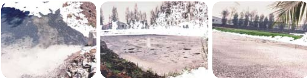
บ่อบำบัดน้ำเสียแบบเปิด ใช้พื้นที่ในการบำบัดไม่ต่ำกว่า 100 ไร่ เกิดปัญหากลิ่นเหม็นและมีประสิทธิภาพต่ำ
