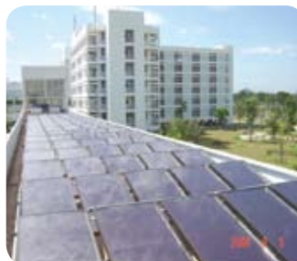
เซลล์แสงอาทิตย์ฟิล์มอินทรีย์ ให้ทั้งไฟฟ้าและน้ำร้อนในระบบเดียว ในราคาที่ถูกกว่า
