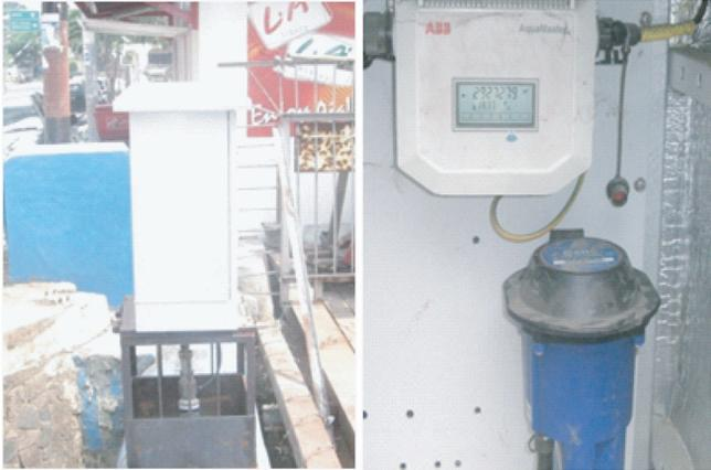
Manajemen tekanan air dengan metode *Pressure Reducing Valve (PRV)*. Dengan pertimbangan belum optimalnya jaringan perpipaan, maka dilaksanakan program penurunan NRW dengan menurunkan tekanan pada saat pelanggan tidak mempergunakan air, atau dapat dikatakan *menurunkan tekanan pada waktu tidak pada puncak tekanan kebutuhan*. Metode ini disebut sebagai metode *Pressure Reducing Valves*, karena berupa teknik membuka-tutup katub tekanan sesuai dengan fluktuasi kebutuhan air pada tingkat pelanggan.
