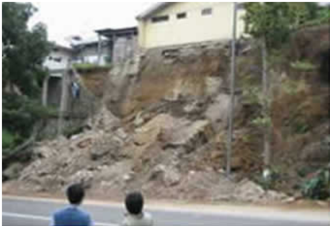
Gambar 2. 2 Kerusakan Jalan Kabupaten dan Nasional di Batipuh, Tanah Datar dan Selaing, Kota Padang Panjang
