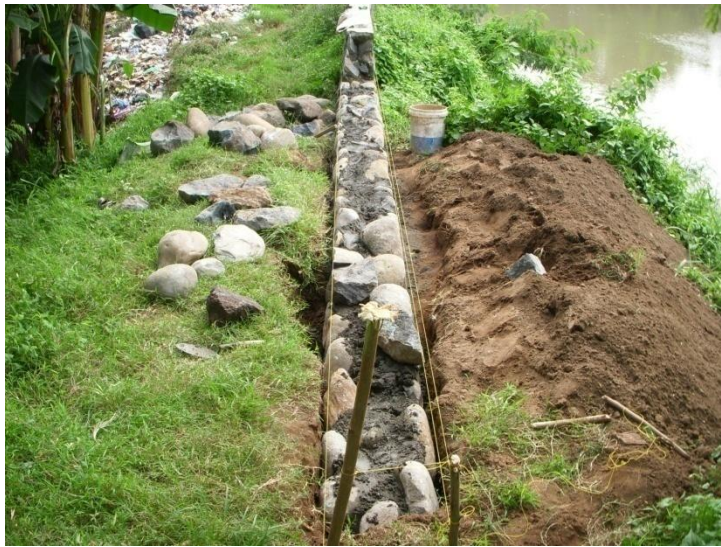
Gambar 4.4 Perbaikan tembok parapet tanggul banjir sungai dengan tembok pasangan batu kali
