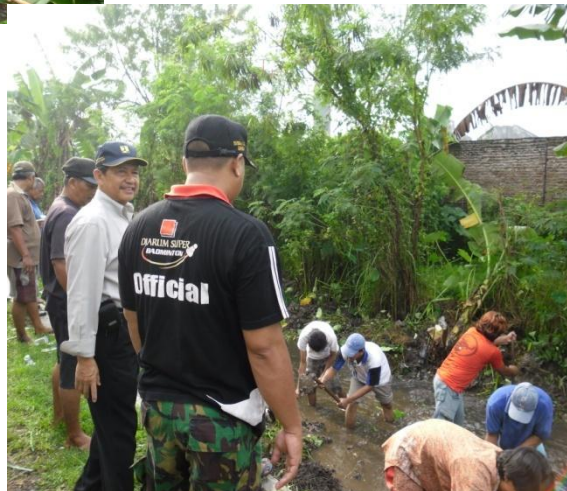
Gambar 4.6 Pembersihan saluran drainase dari endapan sedimen
