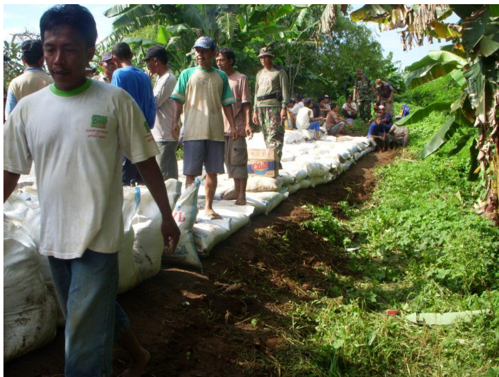
Gambar 4.1 Perbaikan tanggul sungai Brangkal oleh masyarakat
