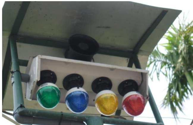
Gambar 4.9 Empat buah lampu pemberi sinyal tanda aman sampai dengan bahaya dan sirene pemberi tanda suara bahaya.
