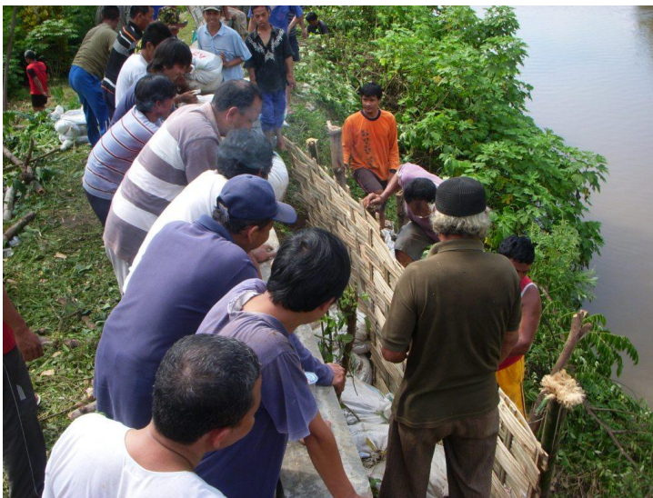
Gambar 4.3 Perbaikan tebing sungai dengan turap anyaman bambu
