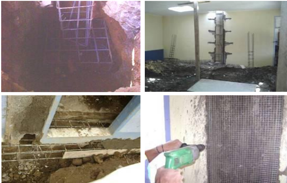
Gambar 29. Tahapan-tahapan dalam pekerjaan fisik perkuatan bangunan.
