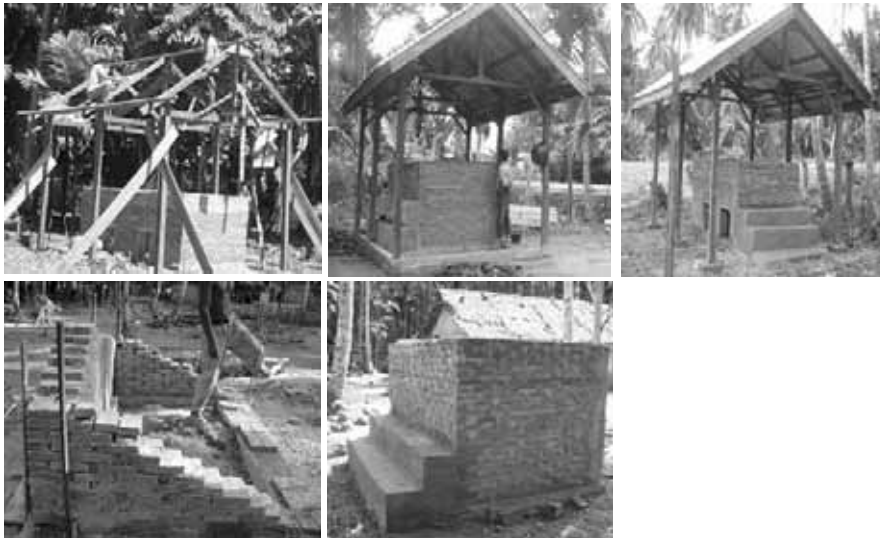
Gambar 13. Penyelesaian konstruksi dapur pengering kopra dan pinang yang dilaksanakan secara partisipatif oleh masyarakat penerima manfaat baik laki-laki maupun perempuan sesuai dengan kapasitas atau kemampuannya masing-masing
