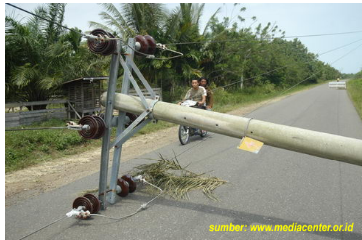
Gambar II. 14 Kerusakan Jaringan Instalasi Listrik Di Provinsi Sumatera Barat
