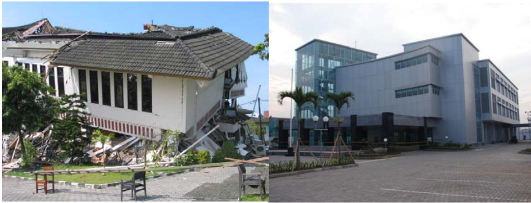
Gambar 3. 8: Bangunan Kantor BKKP yang rusak akibat gempa (kiri) dan bangunan setelah rekonstruksi (kanan).
