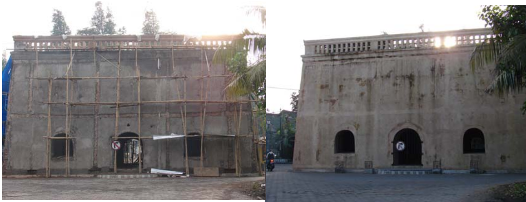
Gambar 3. 12: Pangung Krapyak saat rekonstruksi setelah gempa (kiri), dan setelah selesai direkonstruksi (kanan).
