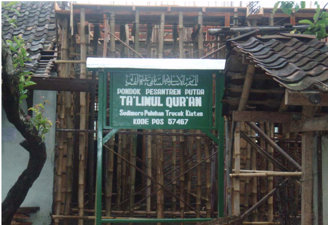
Gambar 3. 18: Rehabilitasi bangunan Pondok Pesantren Ta'limul Qur'an
