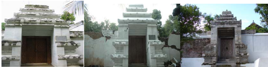
Gambar 3. 15: Gapura sebelah timur makam Pakubuwono 10 - 12 Kompleks Makam Imogiri sebelum gempa (kiri), kerusakan akibat gempa (tengah) dan setelah rekonstruksi (kanan)
