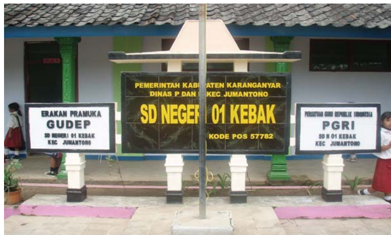
Rehabilitasi Bangunan Sekolah Dasar
