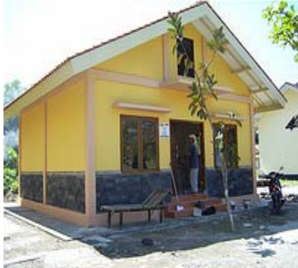
Rehabilitasi bangunan perumahan oleh lembaga internasional
