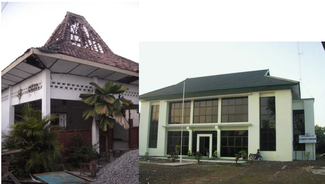
Gambar 3. 7: Bangunan Kecamatan Prambanan yang rusak akibat gempa (kiri) dan bangunan setelah rekonstruksi (kanan).
