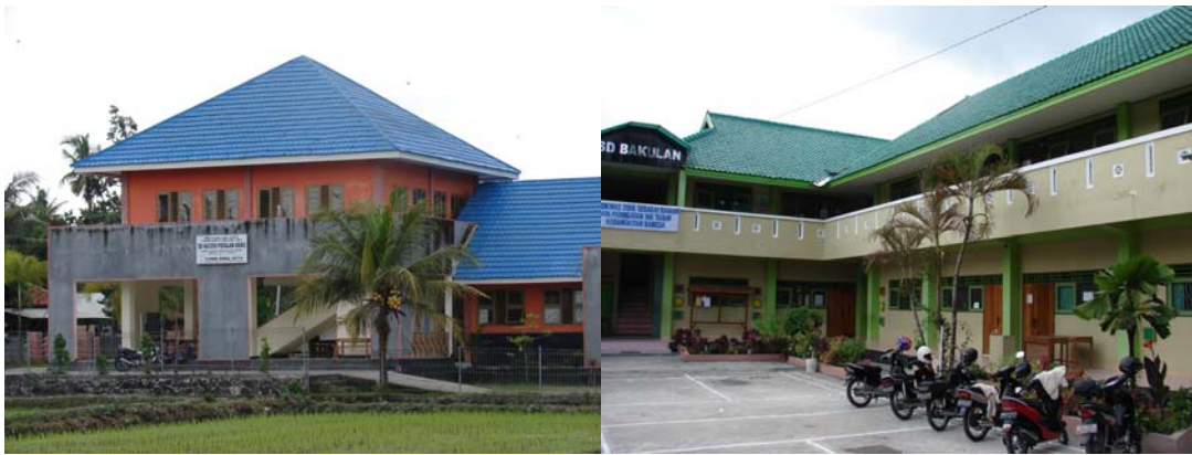
Gambar 3. 5: Bangunan sekolah SD Patalan (kiri) dan SD Bakulan (kanan) setelah rekonstruksi.
