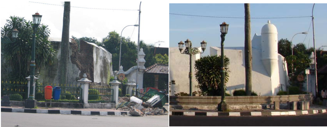
Gambar 3. 11: Salah satu sudut pojok beteng (bastion) akibat gempa (kiri), dan setelah direkonstruksi (kanan).
