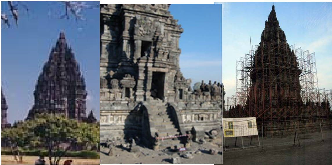
Gambar 3. 10: Salah satu candi di kompleks Candi Prambanan sebelum gempa (kiri), kerusakan akibat gempa (tengah) dan bangunan candi dalam tahap rekonstruksi (kanan).
