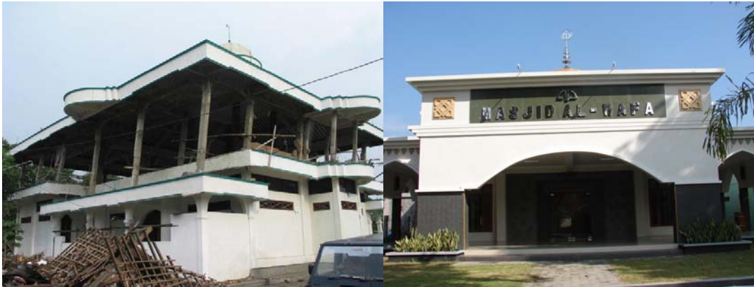
Gambar 3. 9: Salah satu bangunan masjid yang rusak akibat gempa dan bangunan Masjid Al-Wafa setelah rekonstruksi.
