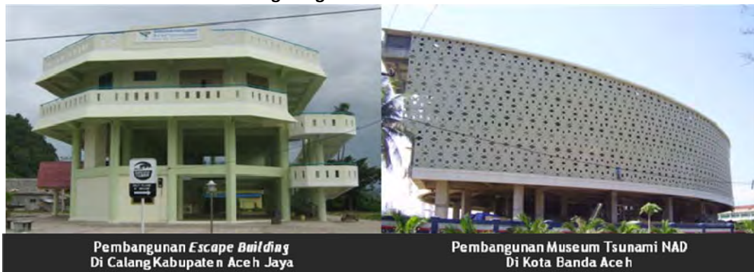
Gambar 3. 7 Hasil Rehabilitasi dan Rekonstruksi Sub Bidang Bangunan Fasilitas Umum oleh BRR
