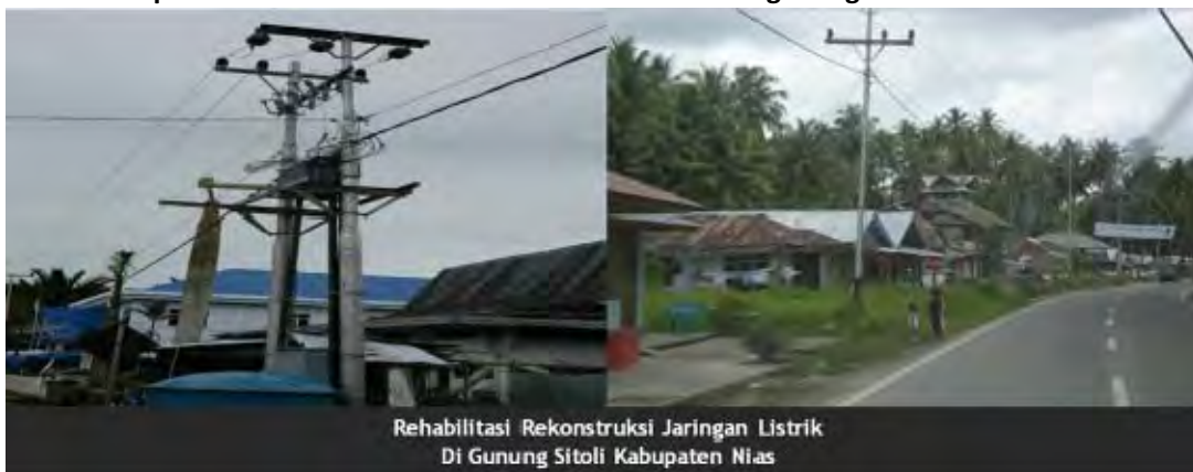
Gambar 3. 6 Beberapa Hasil Rehabilitasi dan Rekonstruksi Sub Bidang Energi dan Listrik oleh BRR
