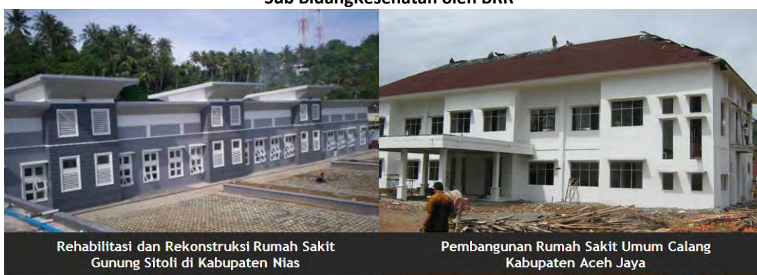
Gambar 3. 12 Beberapa Hasil Rehabilitasi dan Rekonstruksi Sub Bidang Kesehatan oleh BRR
