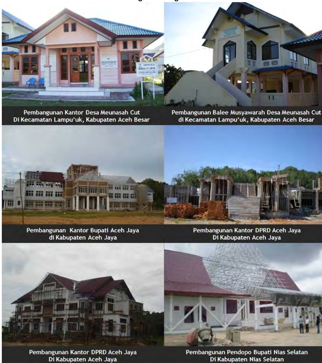
Gambar 3. 15 Hasil Rehabilitasi dan Rekonstruksi Sub Bidang Kelembagaan oleh BRR
