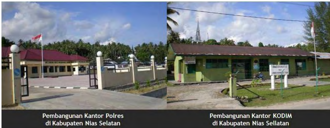
Gambar 3. 17 Hasil Rehabilitasi dan Rekonstruksi Sub Bidang K3M oleh BRR
