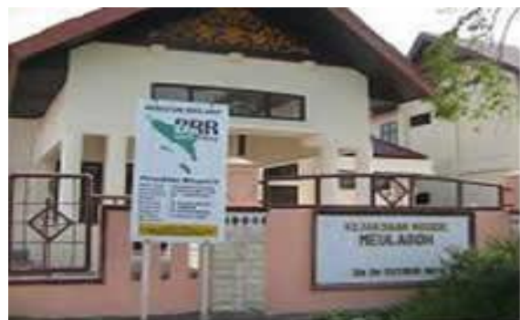
Gambar 3 - 33 Pembangunan Kantor Kejaksaan Negeri di Meulaboh Kabupaten Aceh Barat
