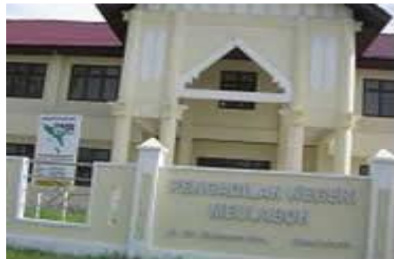
Gambar 3 - 35 Pembangunan Kantor Pengadilan Negeri di Meulaboh Kabupaten Aceh Barat
