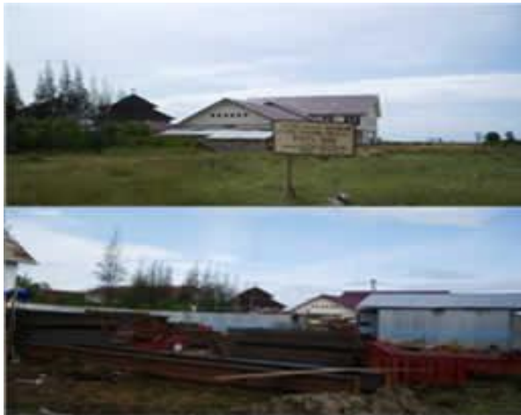
Gambar 3 - 34 Pembangunan Kantor Pengadilan Negeri di Kota Juang Kabupaten Bireun
