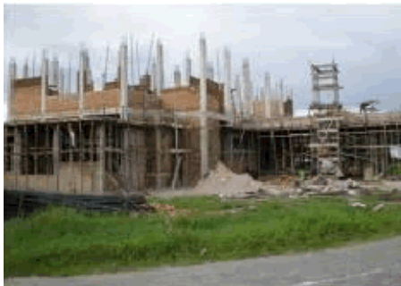
Gambar 3 - 27 Pembangunan Kantor Bappeda Kabupaten Aceh Singkil
