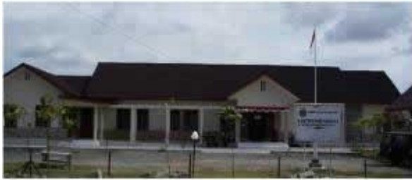
Gambar 3 - 30 Pembangunan Kantor Camat Meuraxa di Kota Banda Aceh
