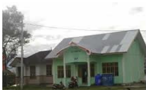
Gambar 3 - 49 Pembangunan Gedung Serbaguna Desa di Kota Sigli Kabupaten Pidie oleh MDF
