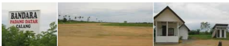
Gambar 3 - 7 Kondisi Infrastruktur Bandara/Airport Kabupaten Aceh Jaya yang belum selesai dibangun
