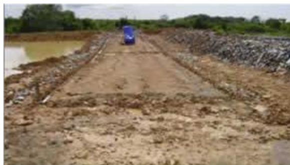
Gambar 3 - 48 Rehabilitasi Lokasi Pembuangan Sampah Tsunami di Lapang, Kab. Aceh Berat
