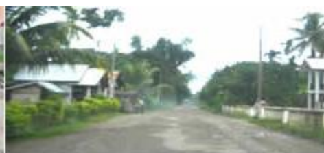
belum diperbaiki, Aceh Jaya
