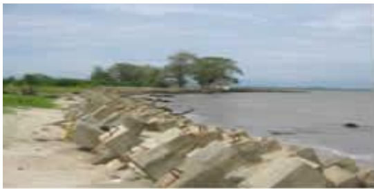
Gambar 3 - 5 Tanggul Pengaman Pantai di Pantai Meulaboh, Kabupaten Aceh Barat
