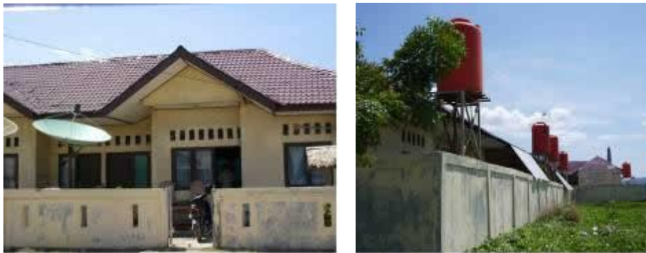
Gambar 3 - 37 Pembangunan Rumah Dinas Polri di Kota Banda Aceh
