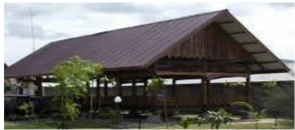
Gambar 3 - 29 Pembangunan Balee Musyawarah di Kecamatan Meuraxa di Kota Banda Aceh
