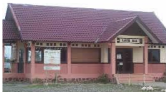
Gambar 3 - 50 Pembangunan Kantor Desa Kajhu Kabupaten Aceh Besar oleh AIPRD
