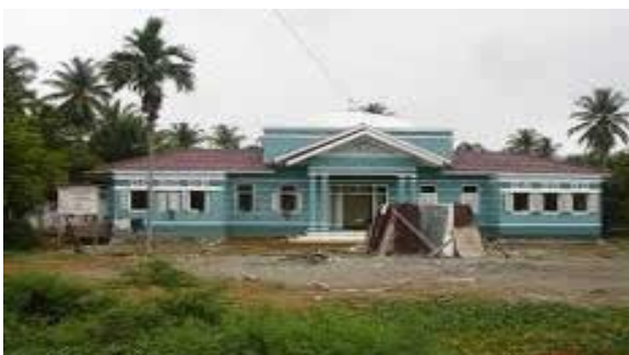
Gambar 3 - 31 Pembangunan Kantor Camat Plimbang di Kabupaten Bireun
