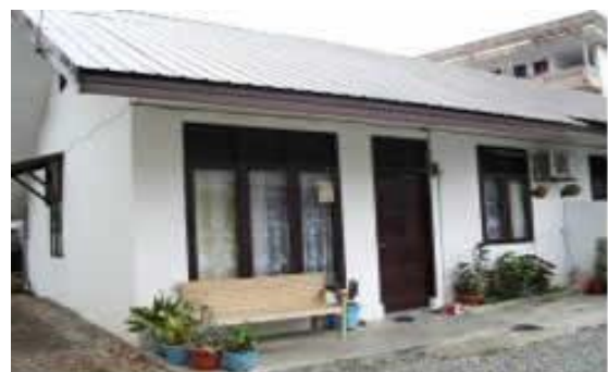
Gambar 3 - 36 Pembangunan Rumah Dinas Kejaksaan Negeri di Kota Banda Aceh
