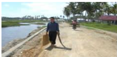
sedang diperbaiki, Aceh Jaya
