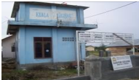
Gambar 3 - 28 Pembangunan Kantor Geuchik Lambada Lhok di Kabupaten Aceh Besar
