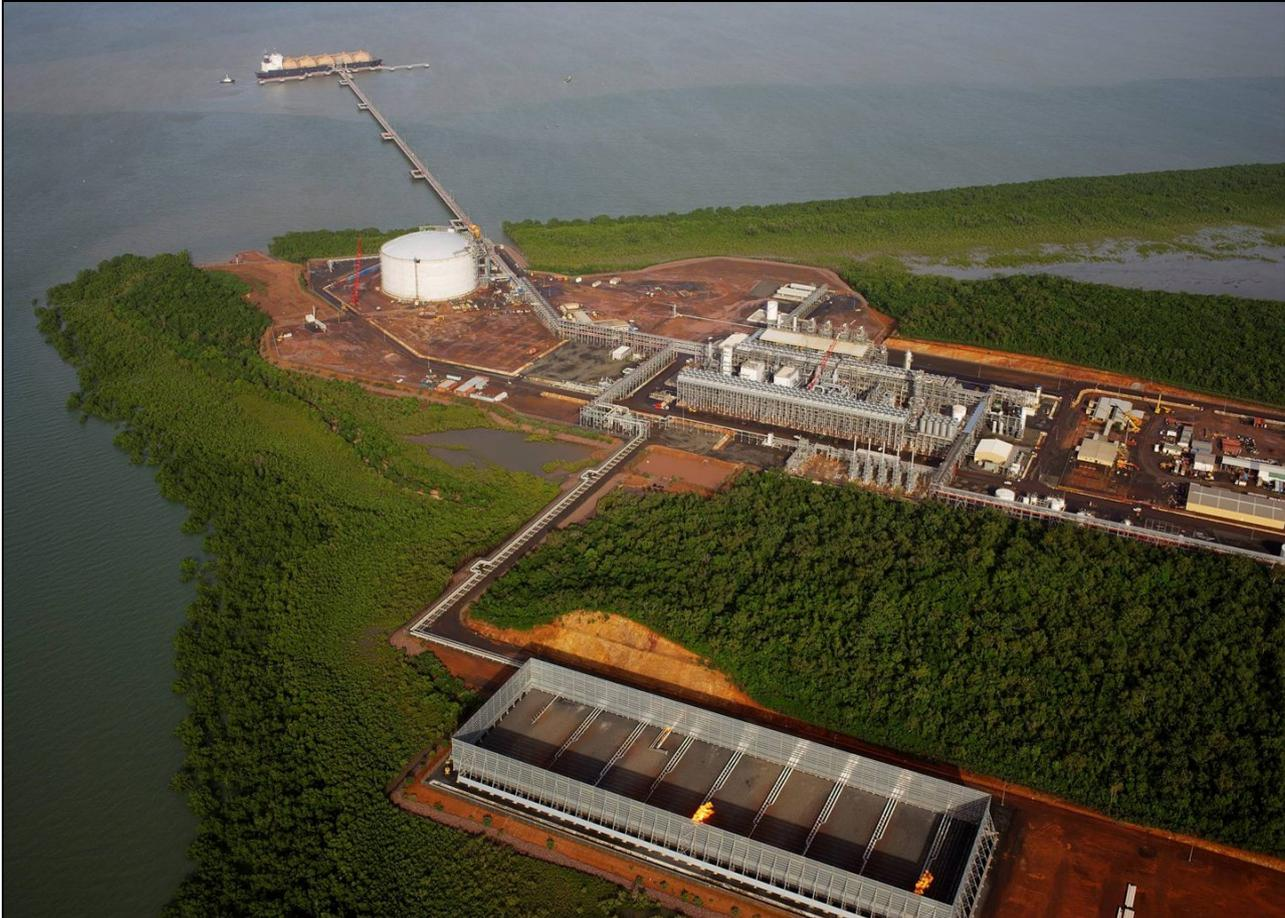
Gambar 6. Kilang LNG Darwin yang memroses gas dari Bayu-Undan. [18] Kapal tanker LNG terhubung melalui sebuah dermaga sepanjang 1,3 km.
