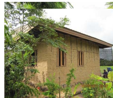
บ้านดินที่กำลังสร้างเองยังไม่แล้วเสร็จ
