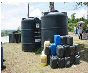
ถังเก็บน้ำบาดาล
