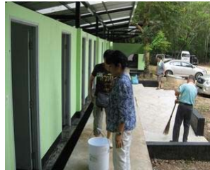
ห้องน้ำ-ห้องส้วม
