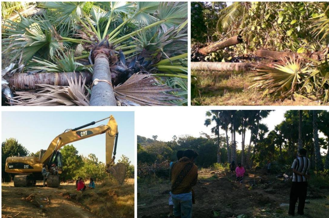
Gambar 4. Foto Penggusuran Pohon Lontar dalam Pembangunan Embung Guriola
