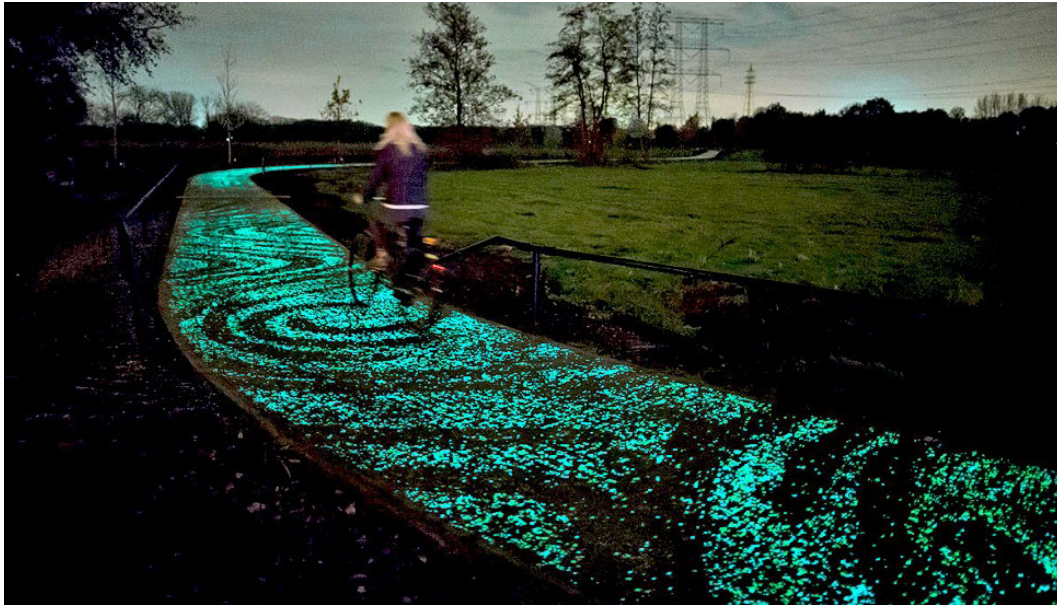
Foto 34: Van Gogh Path di Netherlands, di mana laluan basikal yang bercahaya pada waktu malam ini, dibina menggunakan bahan yang menyerap cahaya matahari pada waktu siang dan menyinar pada waktu malam.
