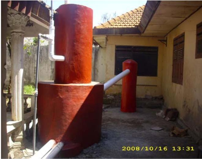
*Konstruksi untuk separasi bubble*
