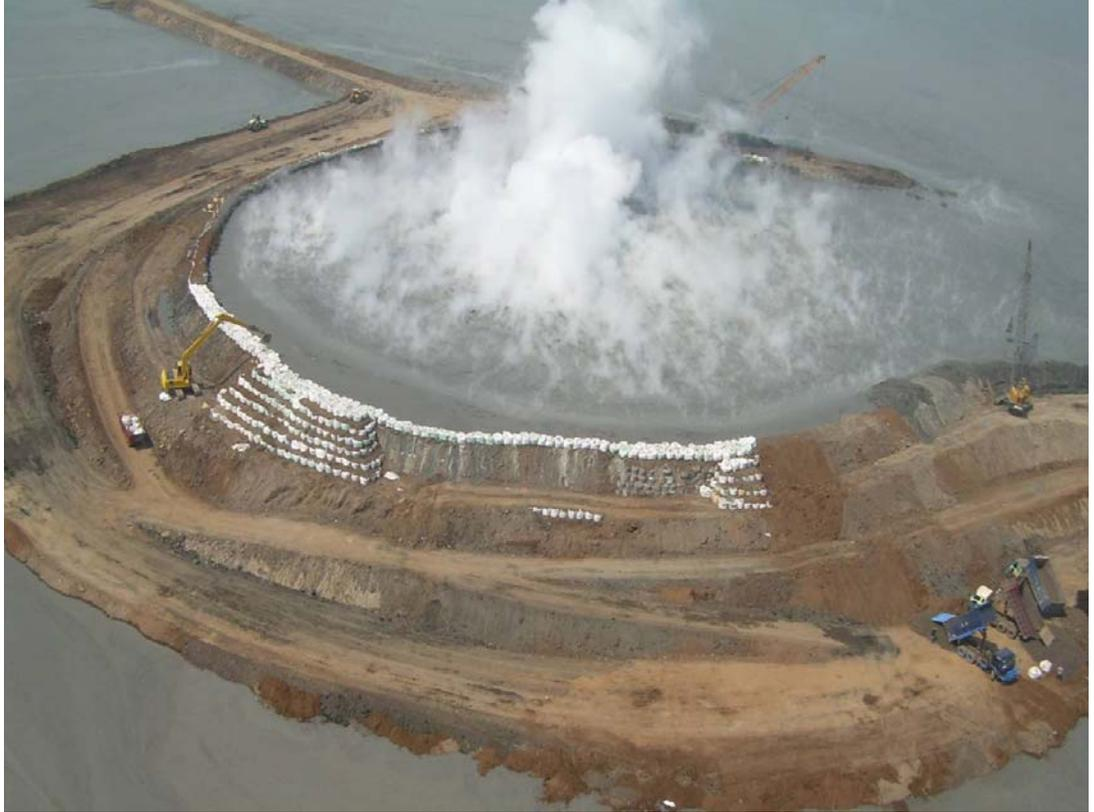
*Hydrostatic counter pressure di sekeliling pusat semburan dengan kantong-kantong yang diisi sirtu*
