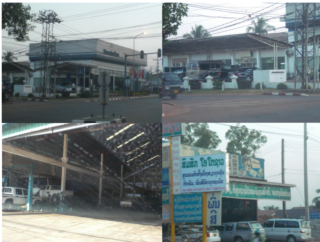
ภาพที่ 3.84 ศูนย์บริการ และอู่ซ่อมรถยนต์ในหลวงพระบาง
