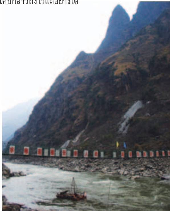
การขุดเจาะสำรวจแม่น้ำสาละวิน เพื่อสร้างเขื่อนลิ่วคู้ ภาพโดย TERRA
