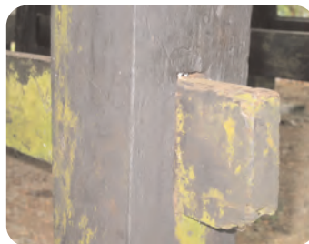
Pengikat kayu menyambung pelbagai bahagian rumah tanpa menggunakan paku atau skru Wooden fasteners join the various parts of the house together instead of nails or screws
