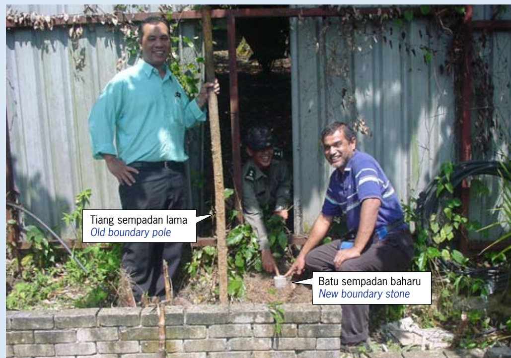
Gambar menunjukkan tiang sempadan lama yang terpaksa digali keluar dan ditanam dengan batu sempadan yang baharu. Picture showing an old boundary pole being dug up and replaced by a new boundary stone.
