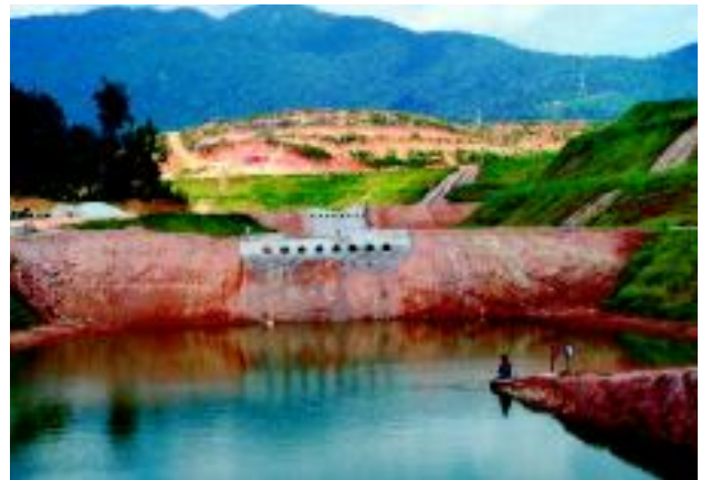
Gambarfoto 4.2 : Sistem Perangkap Mendap Yang Cekap Photo 4.2 : Efficient Silt Trap System
