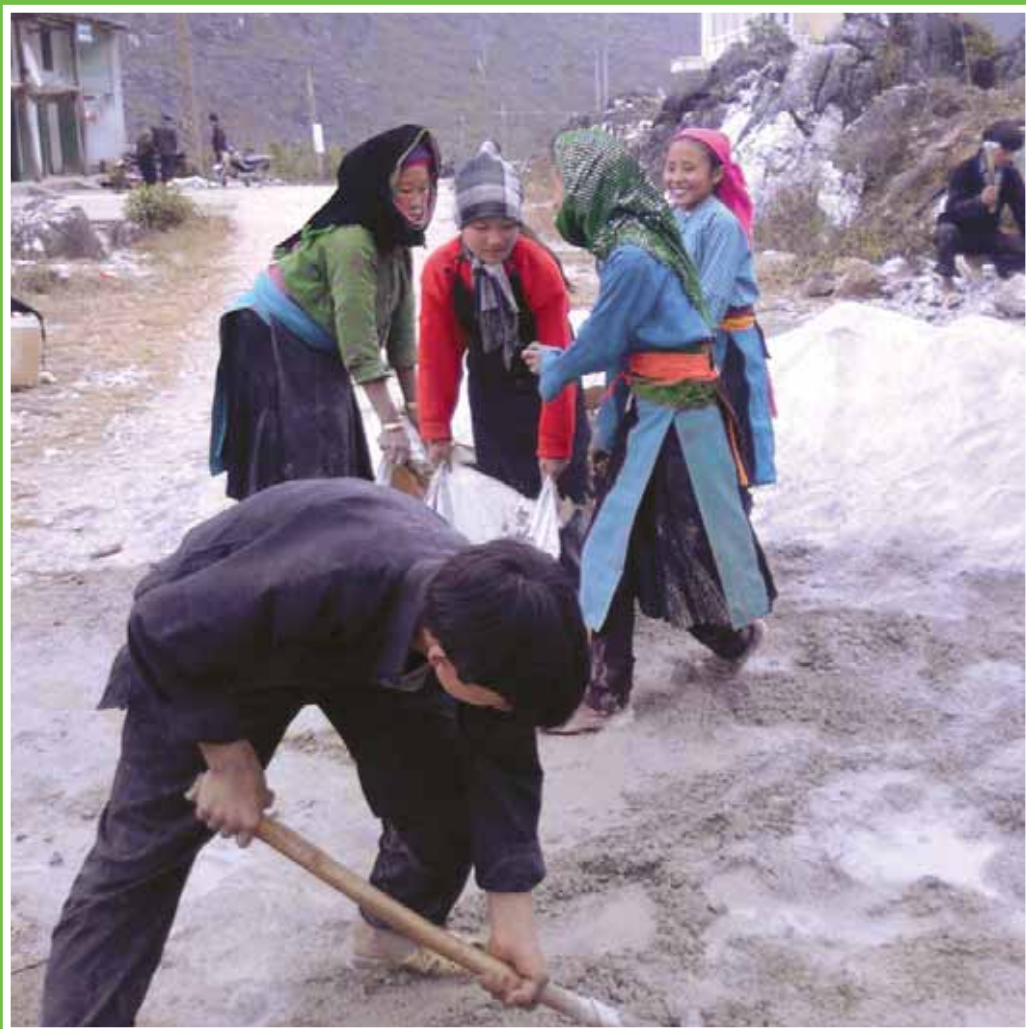
"Build Road" - Photo: Kieu Van
